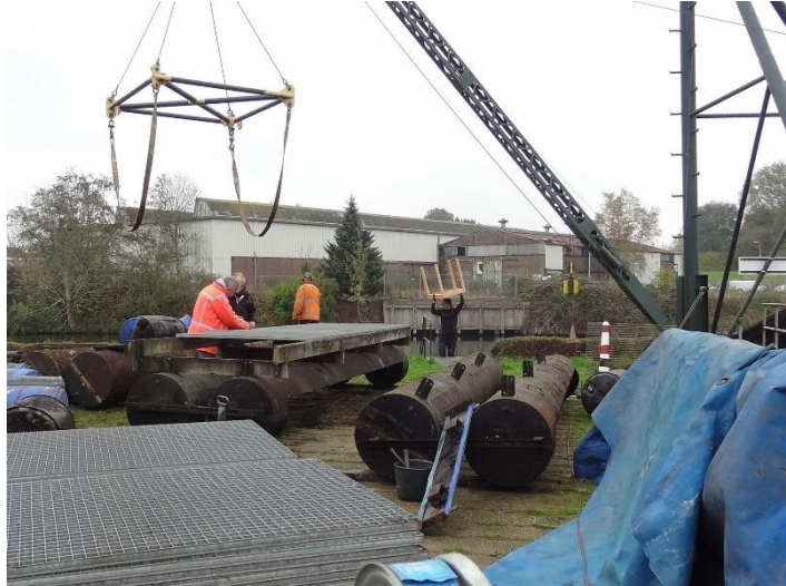
Slopen van de pontons en scheiden van materialen
