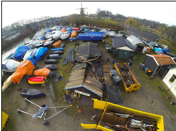
De sloop van de oude loodsen is begonnen
